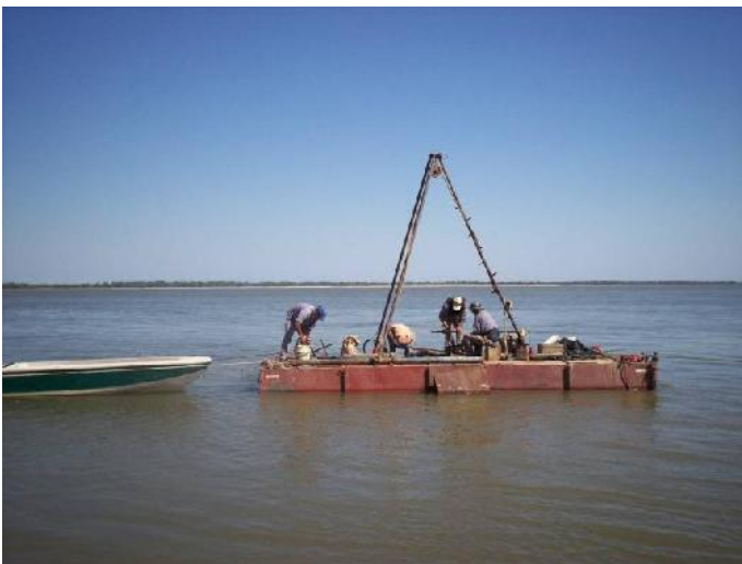
Fotos 3.2. Avance de perforación en agua y extracción de muestra.
