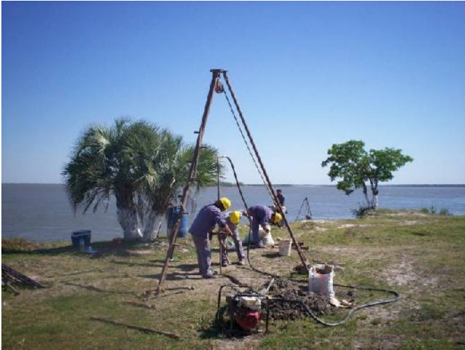
Fotos 3.1. Avance de perforación en tierra y ejecución de ensayo SPT.
